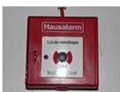
Nichtautomatischer Melder zur Auslösung der Hausalarmanlage ohne Alarmierung der Feuerwehr
