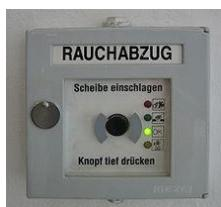
Handsteuerung für Rauch- und Wärmeabzüge sowie Sonderzwecke (z.B. Abschaltung technischer Anlagen)
