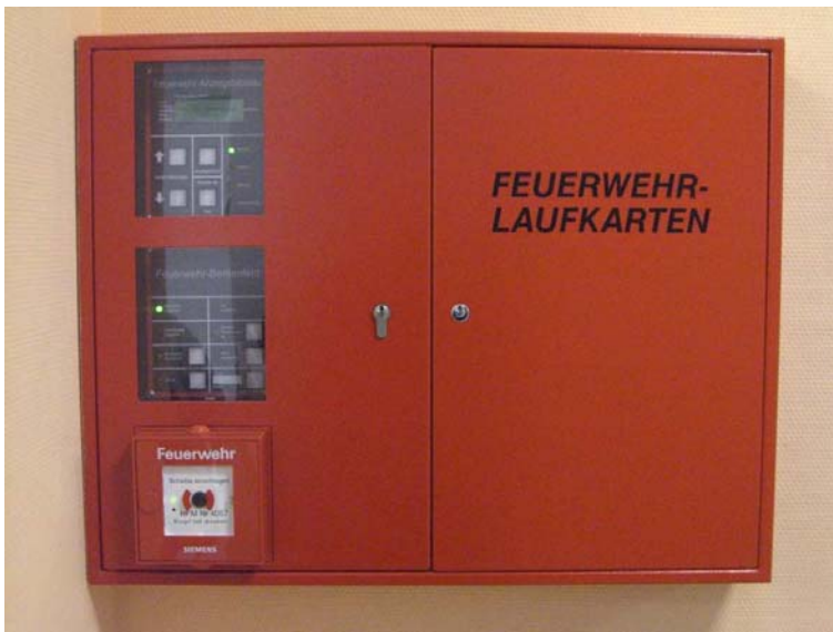
Bild 1: Feuerwehr-Informationszentrale
