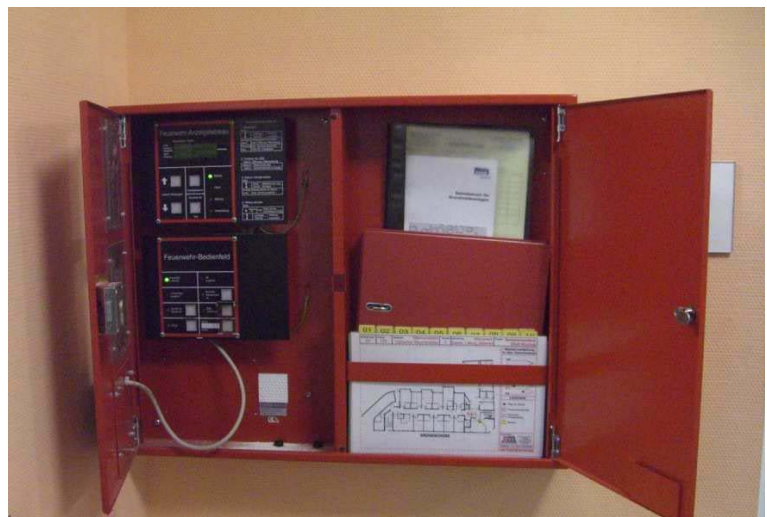
Bild 2: Feuerwehr-Informationszentrale geöffnet
