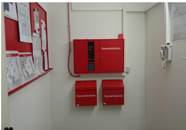
Bild 3.) Feuerwehrraum mit FIBS, Laufkartendepots und Magnet- tafel
