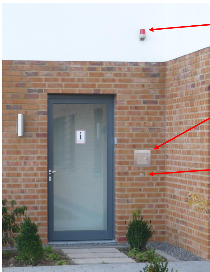
Bild 11.) Montagehöhe FSD / FSE / Blitzleuchte
