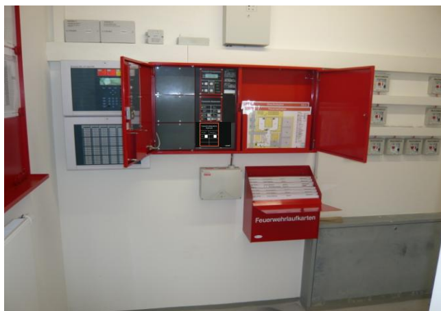
Bild 4.) Feuerwehrraum mit Unterbringung der Brandmelde- Zentrale und Auslösevorrichtungen RWA.
