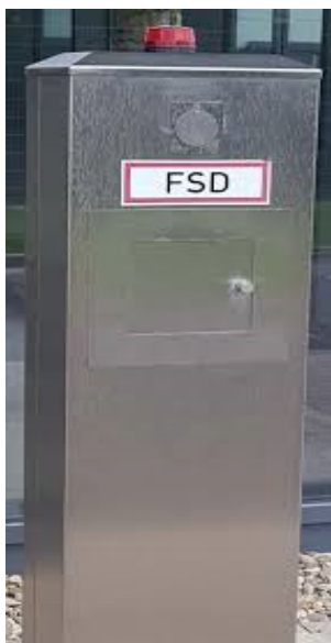
Abbildung 1: FSD-Säule mit roter Blitzleuchte
