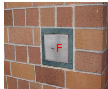
Bild: Feuerwehr-Schlüsseldepot
