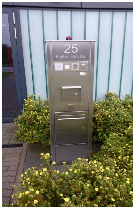
Bild 18.) Edelstahlsäule mit FSD / FSE / Blitzleuchte kombiniert mit Briefkasten und Sprechanlage
