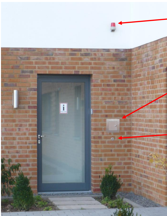
Bild 11.) Montagehöhe FSD / FSE / Blitzleuchte
