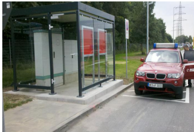
Bild 6.) Feuerwehrraum im Zufahrtsbereich eines Objektes.
