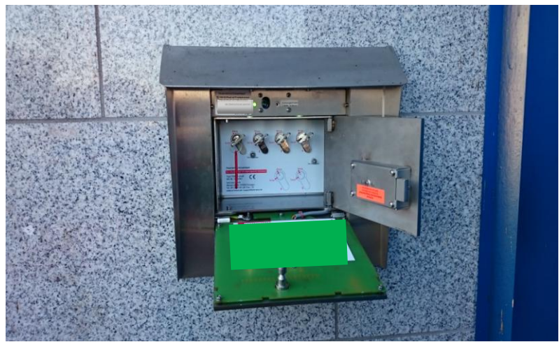
Bild 16.) bis zu 6 Objektschlüsselüberwachungen
