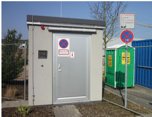
Bild 5) Feuerwehrraum abgesetzt vom Objekt.
