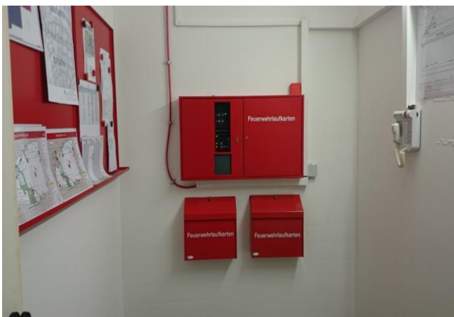
Bild 3.) Feuerwehrraum mit FIBS, Laufkartendepots und Magnet- tafel
