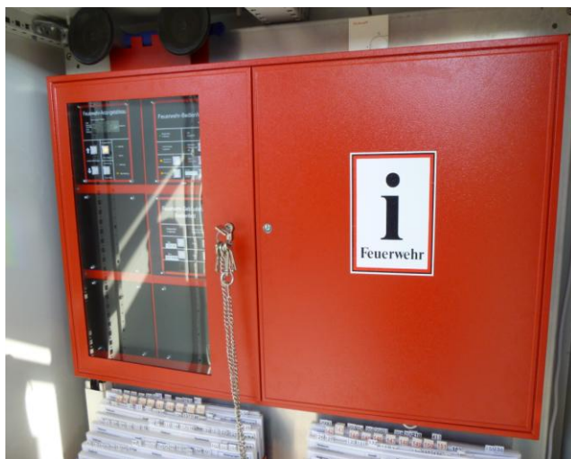
Bild 7.) FIBS mit FGB
