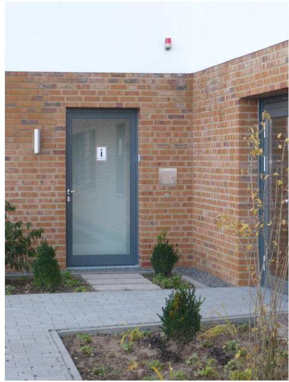
Bild 2.) Der Feuerwehrraum ist nur von außen zugänglich Und entsprechend brandschutztechnisch vom Gebäude abgeschottet (min. F 30)
