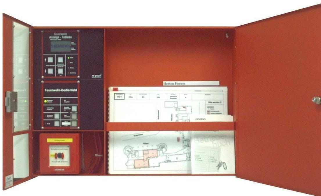
**Abbildung: Feuerwehrinteraktionszentrale geöffnet**
