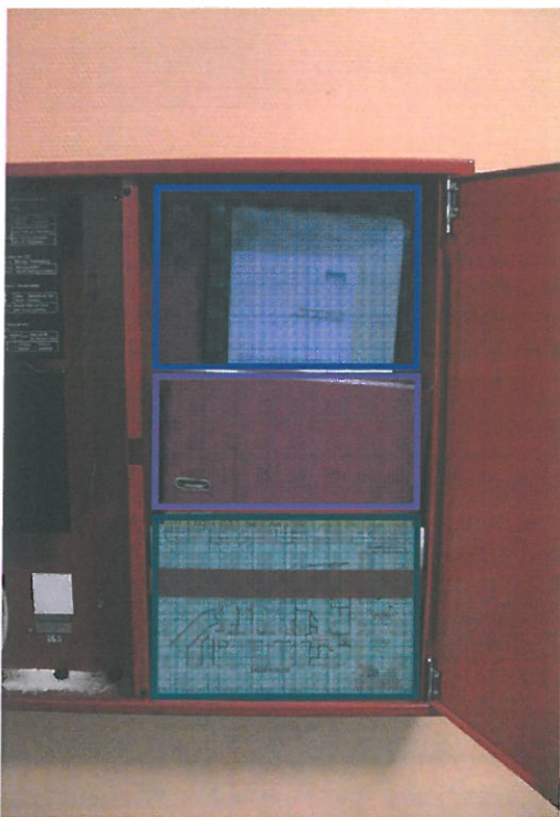
Betriebsbuch für Brandmeldeanlagen Feuerwehrpläne Feuerwehr-Laufkarten
